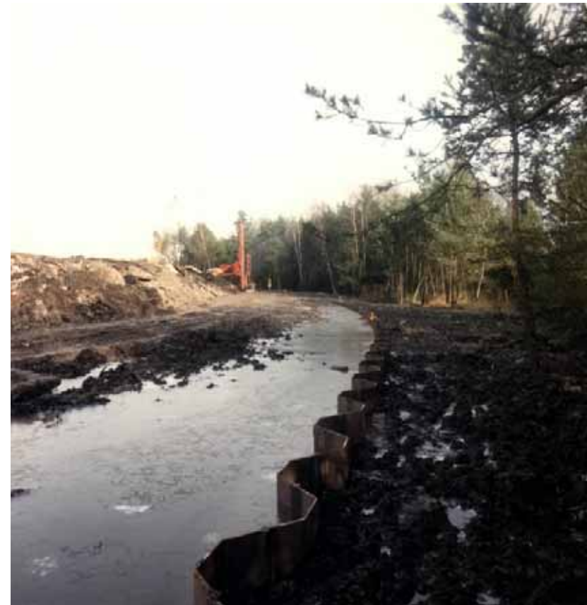
Spundwand mit Hoesch-Dichtung zur Umrandung der Deponie Penzberg
