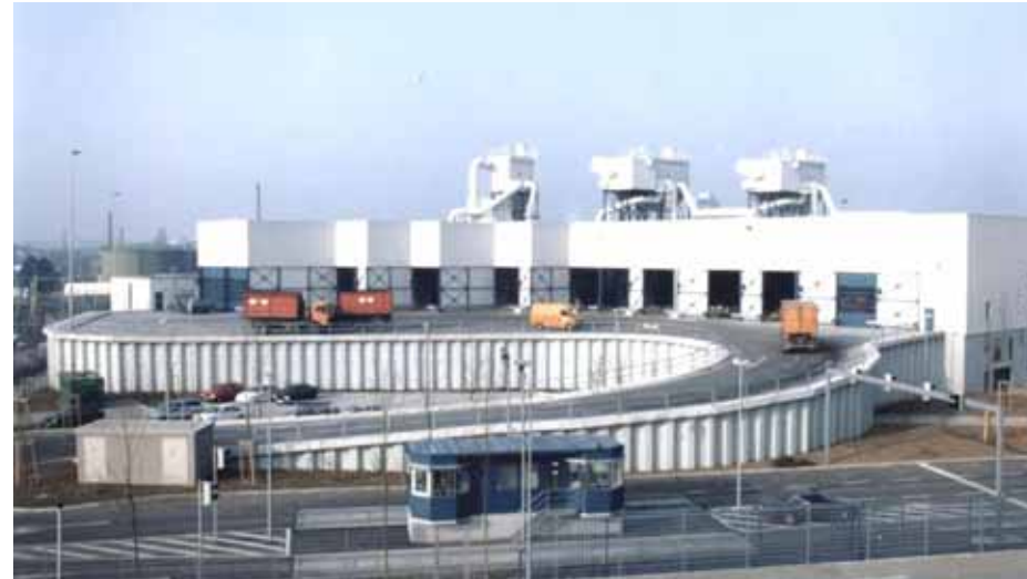
Permanenter Einsatz einer Spundwand für die Rampenzufahrt der Mülldeponie Frankfurt
