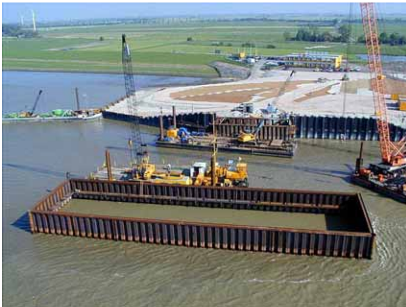
Temporärer Einsatz einer Spundwand beim Bau des Emssperrwerkes Gandersum
