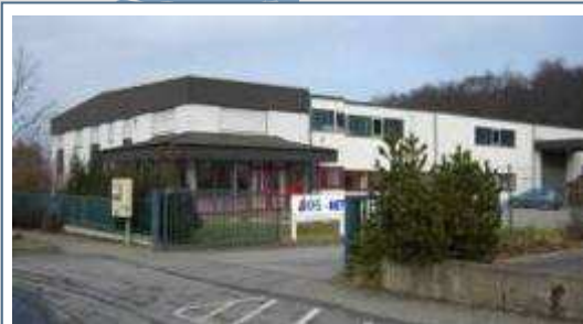
Standort Niederzissen Produktionsfläche: 747 m 2
